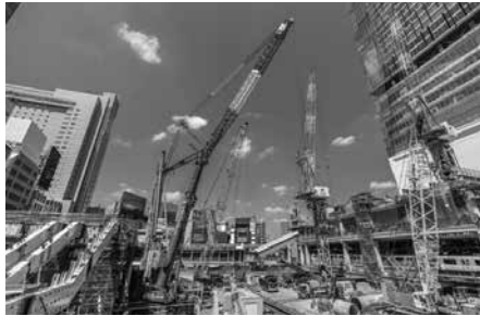
③ 建設業（再開発建設現場）
