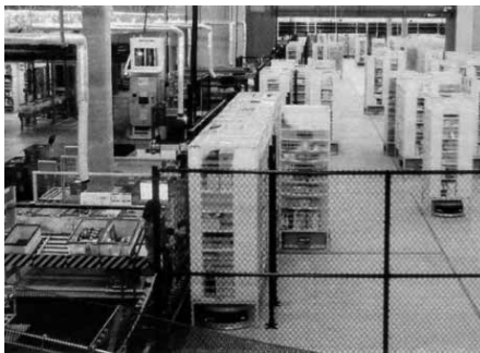
③ 自動化された物流倉庫
