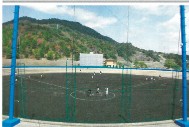
改修中の野球場
