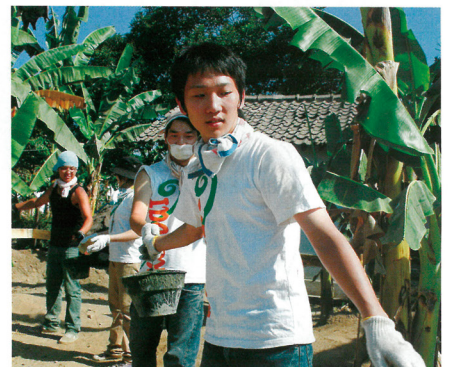
学校建設のため、コンクリートをバケツリレー
