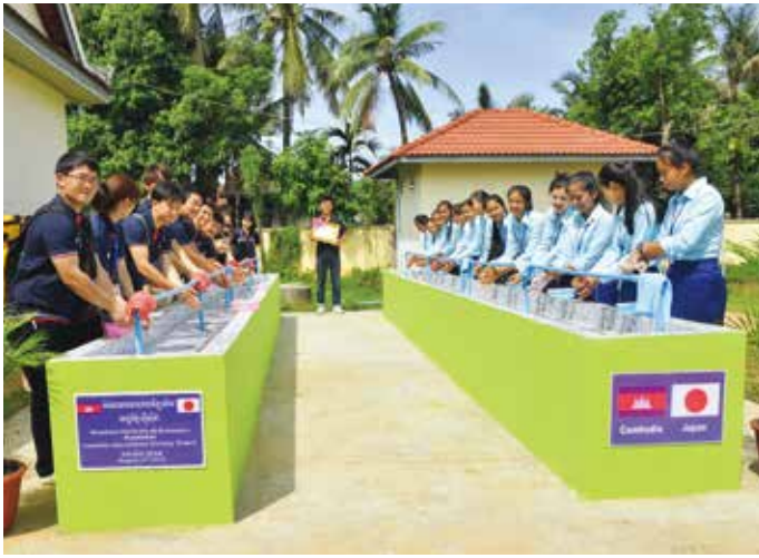
完成した手洗い場
