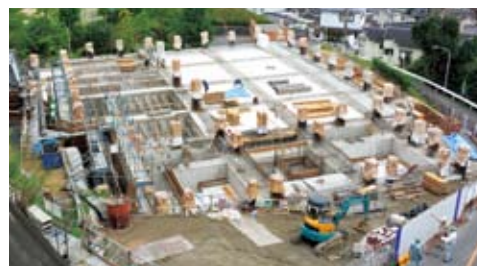
明德館基礎工事の様子
