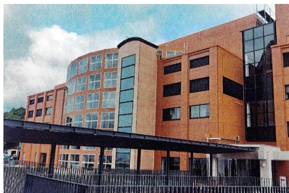
【6号館外壁工事】
