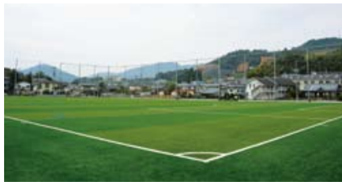
完成した球技場部分
