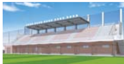
建設中の附属施設
